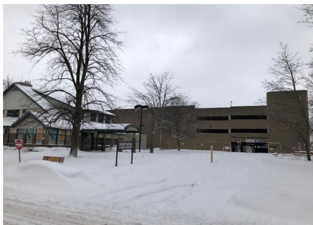
IDENTIFIER: Parking Garage
